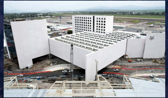
Vista Aérea, Edificio de Usos Mixtos - Grupo Aeroportuario del Pacífico
