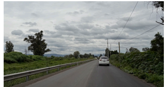
Tramo de 6.2 km de la carretera a El Zapote
