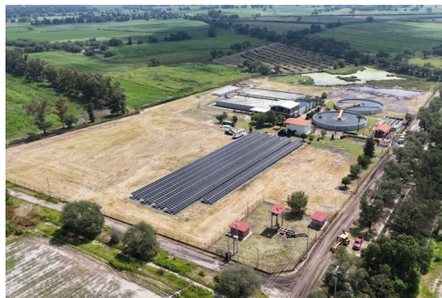
Vista Aérea, 758 Paneles Solares
